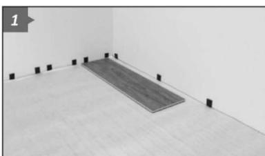
Es ist sehr wichtig, dass die erste Reihe gerade verlegt wird. Um dies zu realisieren, wird die Installation nur für die ersten beiden Reihen zwischen den Reihen eins und zwei hin- und hergewechselt. Beginnen Sie mit einer kleinen Planke (1) und positionieren Sie diese Planke nahe an der Wand.
